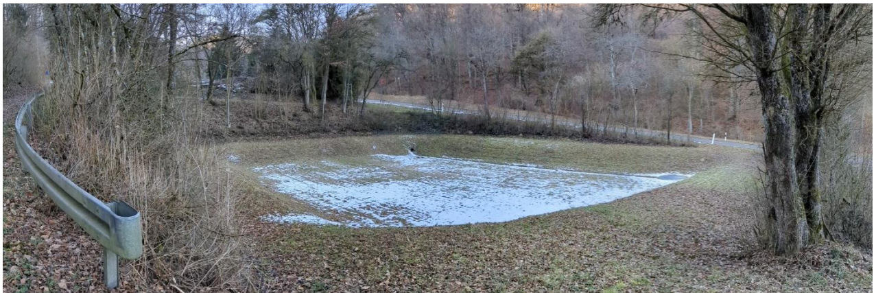
Abb. 15. Regenrückhaltebecken westlich der Vorhabenfläche
